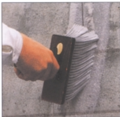
príprava podkladu - základný náter UG, predovšetkým pri veľmi nasiakavých podkladoch
