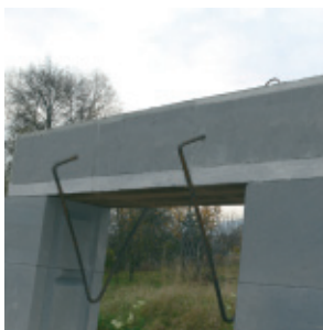
Obr. č. 1 – zabezpečenie vyskladných prekladov proti prevrhnutiu
