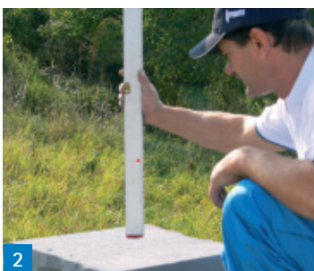
Výškové osadenie tvárnic
