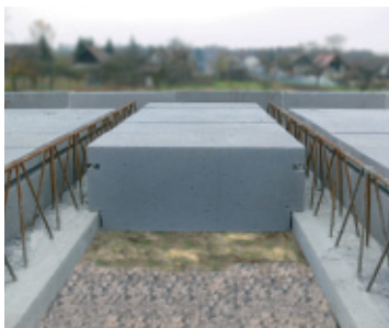
Ukladanie stropných vložiek
