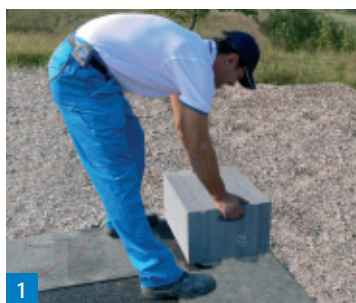
Osadenie rohovej tvárnice
