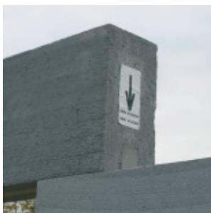
Uloženie nenosného prekladu
