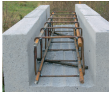
Stuzujúci veniec z U-profilov bez tepelnej izolácie
