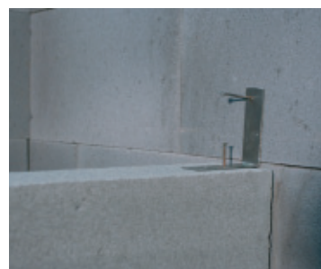
Kotvenie nenosnej priečky
