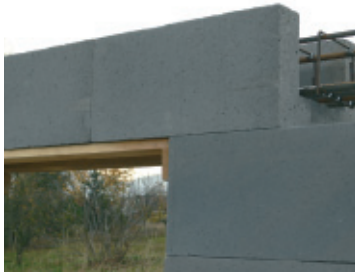
Nosný preklad z U-profilov bez tepelnej izolácie
