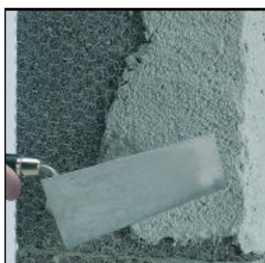
D.1 Pri nanášaní omietky dávať pozor na styk so susediacou stenou.
