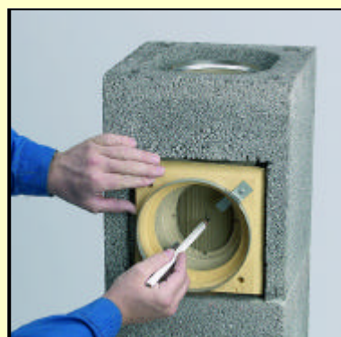
3.3 Miesto napojenia naznačíme na nasucho osadenú vložku.
