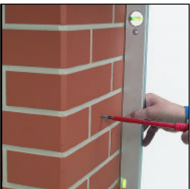
E.5 Komínový plášť osadíme a aretujeme skrutkami vyrovname.
