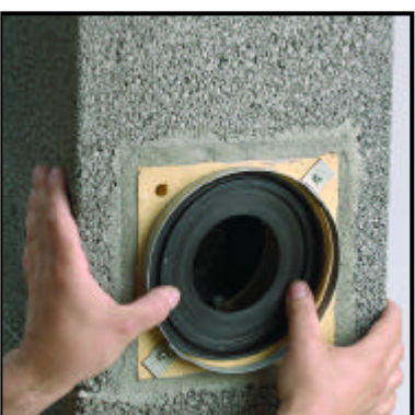
A.1 Do napojovacieho dielu osadíme adaptér. Použijeme mazacu pastu.
