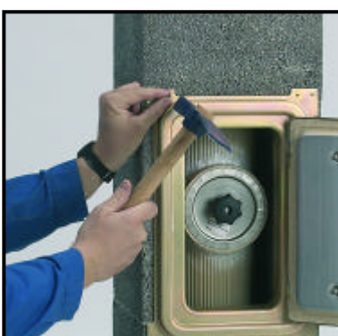
C.2 Na tvárnici osadíme komínové dvierka.
