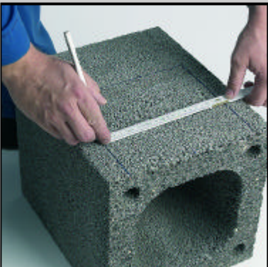
I.2 Na komínovej tvárnici vyznačíme otvor (16 x 16) a vyrežeme.
