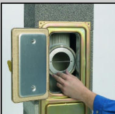
I.10 Osadíme krúžok pre vyrovnávanie tlaku zo sady MULTI.
