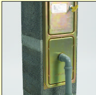
1.2 Pripravíme odvod kondenzátu do kanalizácie.
