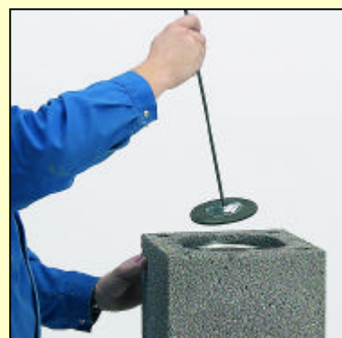
4.7 Špáry zahladíme vyhladzovacím špárom.
