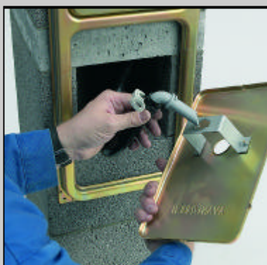
I.11 Sifónovú hadicu nasadíme na výtokové koleno pomocou svorky, otáčime v smere výtoku.
