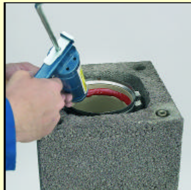
1.4 Do drážky profilovanej rúry naniesieme dostatočné množstvo tmelu ROTEMPO.
