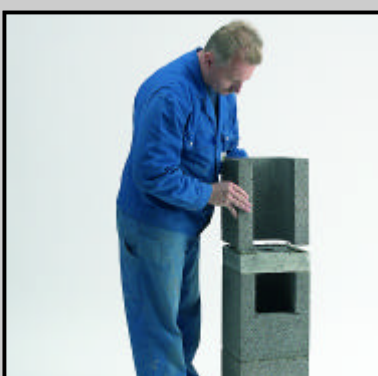
I.6 Na tenkú vrstvu malty osadíme tvárnici s otvorom.
