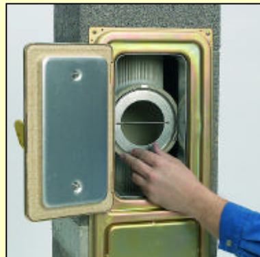
1.3 Osadíme krúžok pre vyrovnávanie tlaku zo súpravy MULTI.
