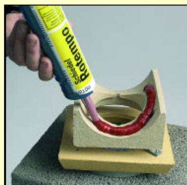
3.7 Na pripojovací diel naniesieme Schiedel ROTEMPO.
