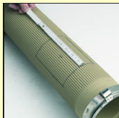
3.4 Na profilovanú rúru vyznačíme otvor 11,5 x 14,5 (v x š).
