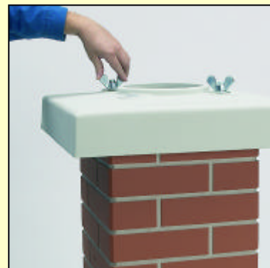
5.4 Kryciu privetrávaciu dosku priskrutkovať, vycievajúce skrutky opatrní krídlovými matkami, zvyšné otvory opatríme umelohmotnými ciapkami.
