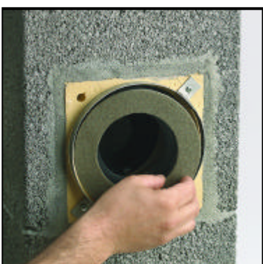
A.2 Na gumový adaptér osadíme filcový krúžok.
