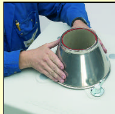
5.8 Kónus navlečieme na vložku tak, aby dosadol na kryciu dosku.
