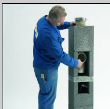
I.8 Osadíme napojovací diel na dvierka zo súpravy PA. Hadica pre kondenzát vycieňme cez otvor v sokľovej doske.
