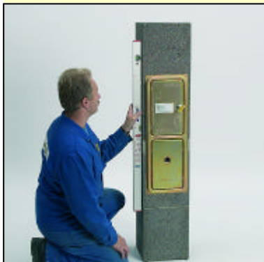
1.1 Pripravíme maltové lôžko, položíme hydroizoláciu, naniesieme maltu MG II, osadíme prefabrikovanú päťu komína na maltu.
