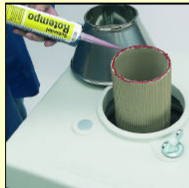
5.7 Osadíme poslednú vložku. Na jej koniec dôkladne naniesieme špárovaciu hmotu ROTEMPO.
