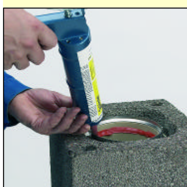
4.1 Do drážky profilovanej rúry dôkladne naniesieme špárovaciu hmotu ROTEMPO.
