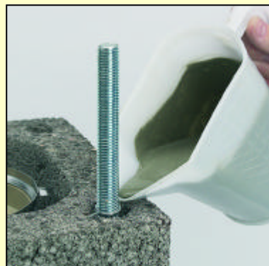
5.2 Armovacie kanálíky zalatiť zálievkovou maltou. Pozor na vystredenie výstuže v kanálíkoch.
