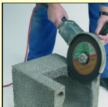
3.2 Uhlovou brúskou vyrežeme otvor pre pripojenie spotrebica.
