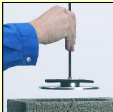
2.4 Ochranné viečko vyberieme pomocou vyhladzovacieho špáru s magnetom, špáry zahladíme, kroky 1.4 - 2.4 opakujeme až po miesto napojovacieho dielu MULTI.
