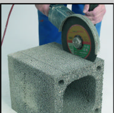
I.5 Vytvoríme otvor pre napojovací diel PA MULTI (šírka vyrezaného otvoru 16 cm).
