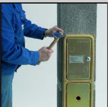
I.9 Kryt z päty komína centricky pripojíme.
