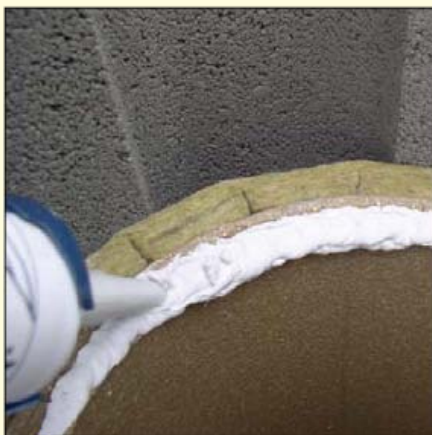
4.1 Do spoja šamotovej vložky (spoj musí byť vyčistený a suchý) naniesť v dostatočnom množstve škárovací tmel.
