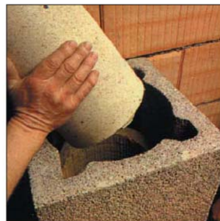
Vložku osadiť, dorovnať a prebytočnú škárovaciu hmotu zotrieť. Styčnú škáru vyhladiť špongiou.
