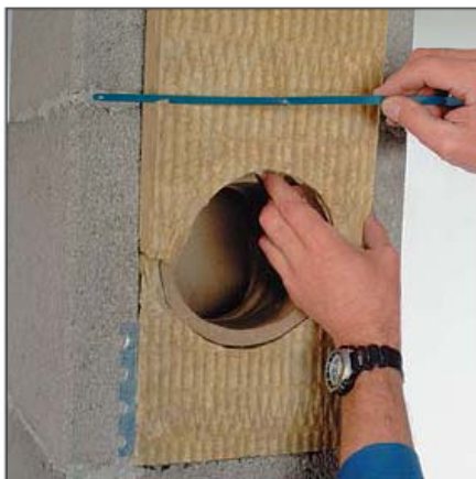
5.1 Výšku čelnej dosky upraviť zarezaním plátkom pílkou (súčasť dodávky).
