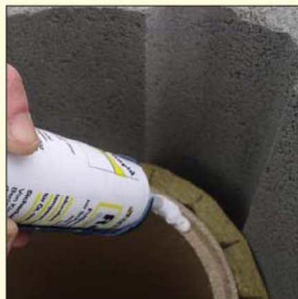
3.2 Do spoja vložky UNI naniesť aplikačnou pištoľou dostatočné množstvo škárovacej hmoty RAPID.
