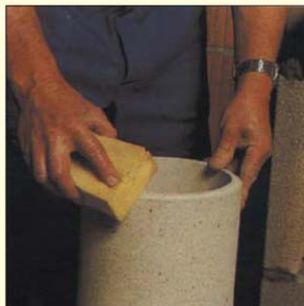
4.6 Spodnú časť osadzovanej vložky očistiť vlhkou špongiou. Škára nesmie byť mokrá.
