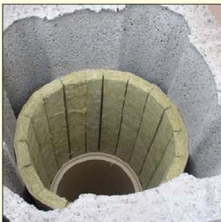
4.5 Rovnakým spôsobom osadiť druhú izolačnú rohož.
