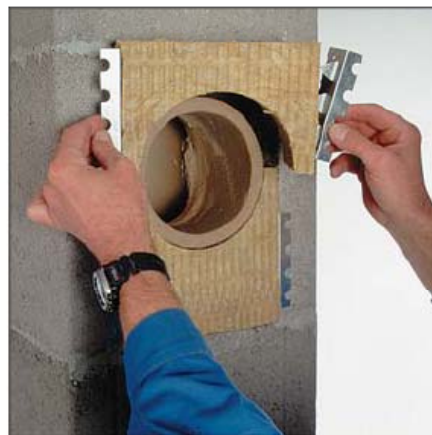
5.2 Uholníky pre uchytenie dosky zaraziť do boku čelnej dosky a dosku osadiť do otvoru v tvárnici.
