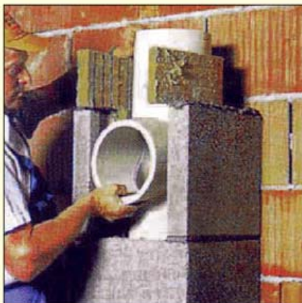
3.5 Vložku pre napojenie dymovodu osadiť. Vytlačenu škárovaciu hmotu zotrieť a škáru začistiť - viď 2.10.
