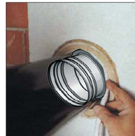
5.4 Pri napájaní dymovodu do komína musí byť možnosť dilatácie. Dopojenie dymovodu zverte odborníkom - kotlárom alebo krbárom.
