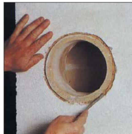
5.3 Pred zatvrdnutím omietky vytvoriť okolo šamotu, tzn. medzi šamotovým sopúchom a omietkou deliacu ryhu.
