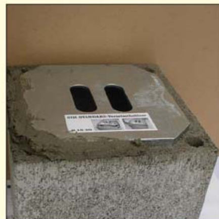
3.3 Na tvárnicu naniesť okolo maltovacej šablóny v primeranom množstve malty. Malta nesmie zapadať do kanálikov zadného odvetrania.
