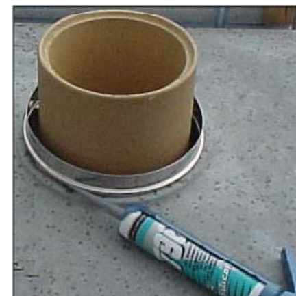
V súprave kominovej hlavy je dištančný kružok, ktorý sa osadí do otvoru v krycej doske. Kružok je potrebné podtmeľiť pre vonkajšie použitie (Schiedel nedodáva).
