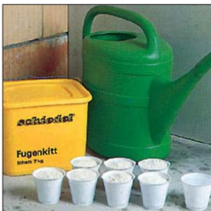
V prípade použitia suchej škárovacej hmoty ju namiešať v pomere presne podľa priloženého návodu (1 : 7).
