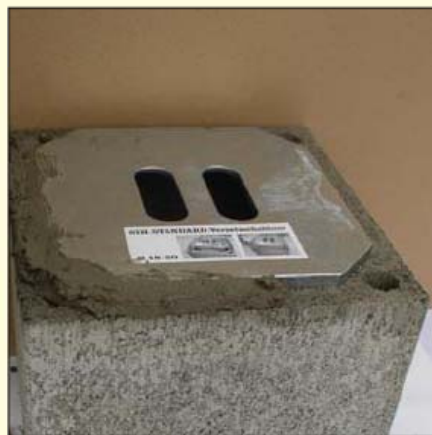
4.2 Na tvárnicu naniesť okolo maltovacej šablóny v primeranom množstve malty. Malta nesmie zapadať do kanálikov zadného odvetrania.
