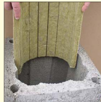
4.4 Izolačnú rohož ohnúť (výrezami dovnútra) a zasunúť do tvárnice tak, aby spoje boli vždy uprostred steny tvárnice. Materiál z rohoží nesmie upchať kanáliky zadného odvetrania.
