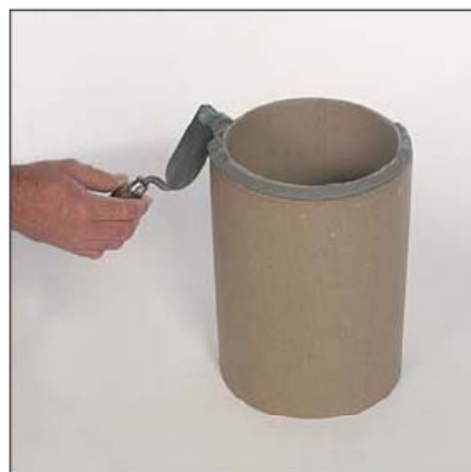
Škárovaciu hmotu nanášať pomocou stierky na dolný koniec šamotovej vložky. Styková plocha musí byť očistená vlhkou špongiou.
