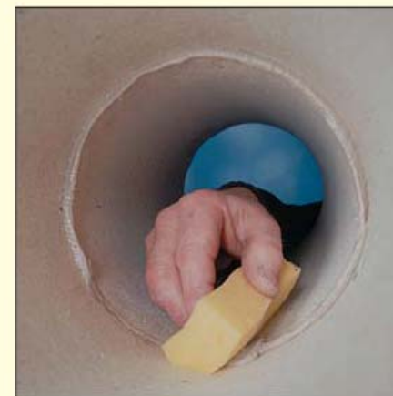
4.8 V škáre musí dôjsť k vytlačeniu škárovacej hmoty. Škáru medzi vložkami vyhladiť vlhkou (nie mokrou!) špongiou. Nadbytočná voda spôsobuje vyplavenie škárovacej hmoty. Spoj musí byť celistvý, bez nevyplnených miest.
