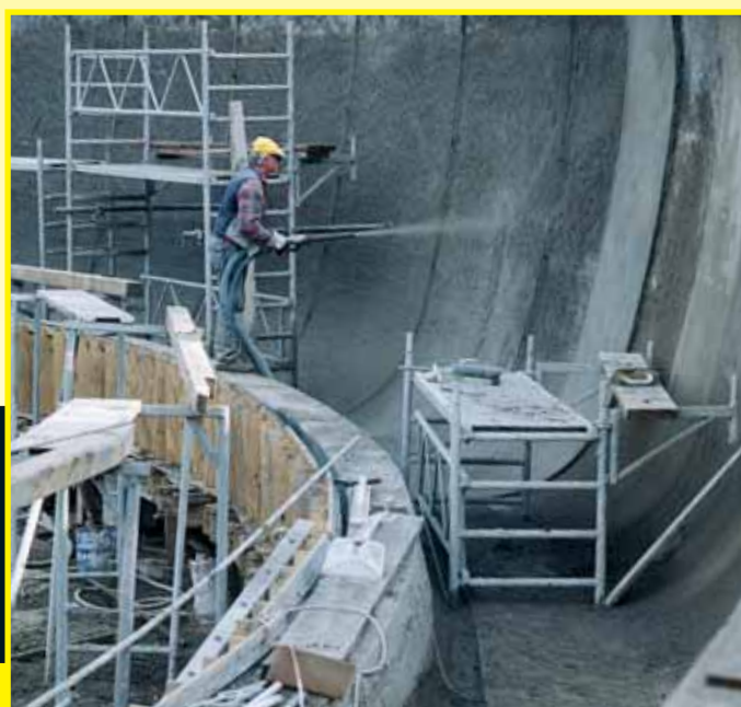
Oprava bobovej dráhy torkrétovaním.
