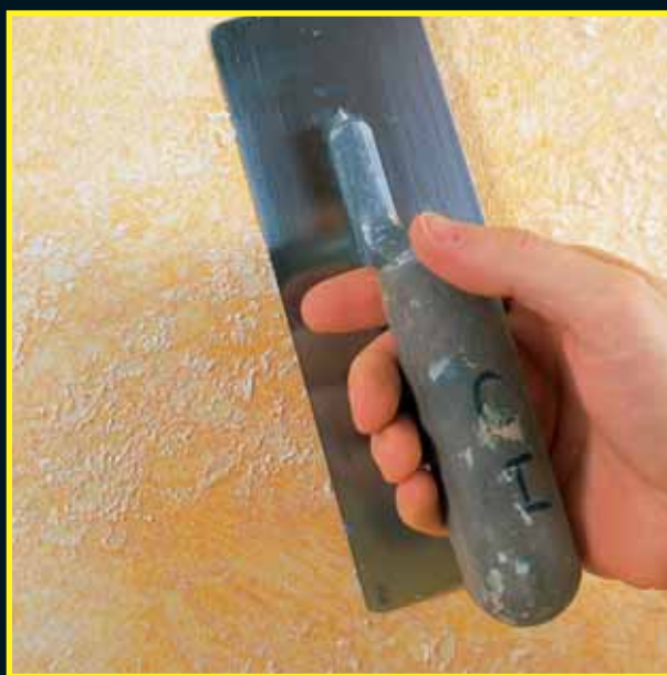
Roztláčenie "farebných kapsúl" po miernom vyschnutí (cca. 30 min.) s benátskou špeciálnou lyžicou.
