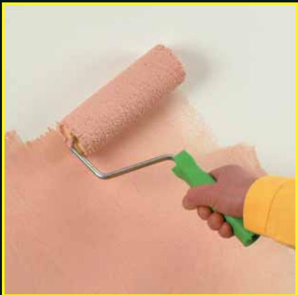
Nanášanie fasádnej lazúry SAKRET Fassadenlasur Villa valcom s krátkym vlasom na plochy, na ktorých sa už nachádza farba SAKRET Hausfarbe.
