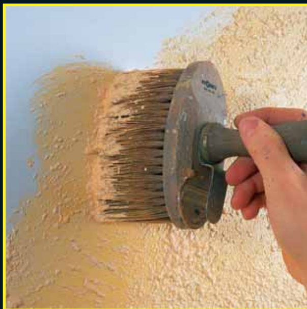
Nanesenie špeciálnej lazúry Aquatone na stenu plošným štetcom.
