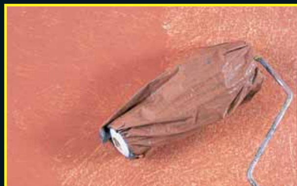
Štrukturovanie lazúry dekorovacím valčekom
