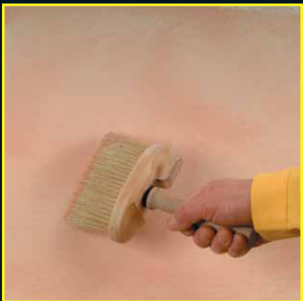
Štrukturovanie čerstvej fasádnej lazúry s plochým štetcom SAKRET.
