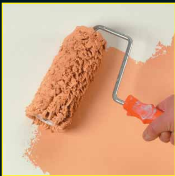
Náter ľubovoľne vytónovaného kontrastného základu SAKRET Kontrastgrund valčekom s krátkym vlasom.
