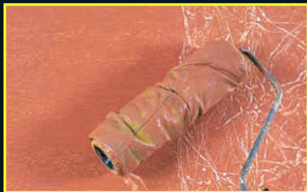
Alternatívne štrukturovanie lazúry so stylingovým valčekom
