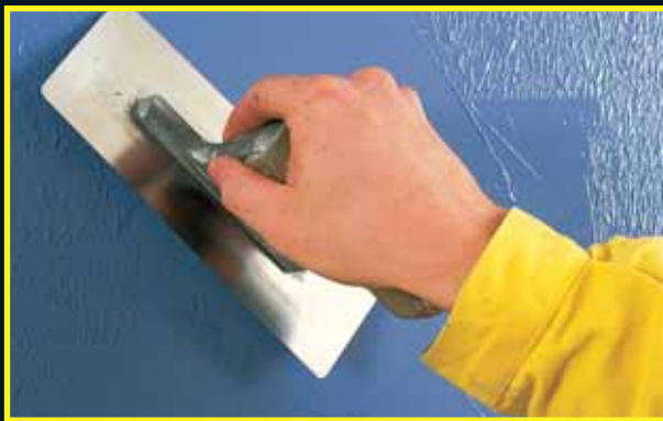
Za čerstva sa farebná masa - bez toho, aby sa poškríbal podklad - štrukturuje špeciálnou lyžicou.
