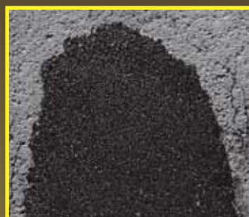
Opravené so SAKRET BIT
